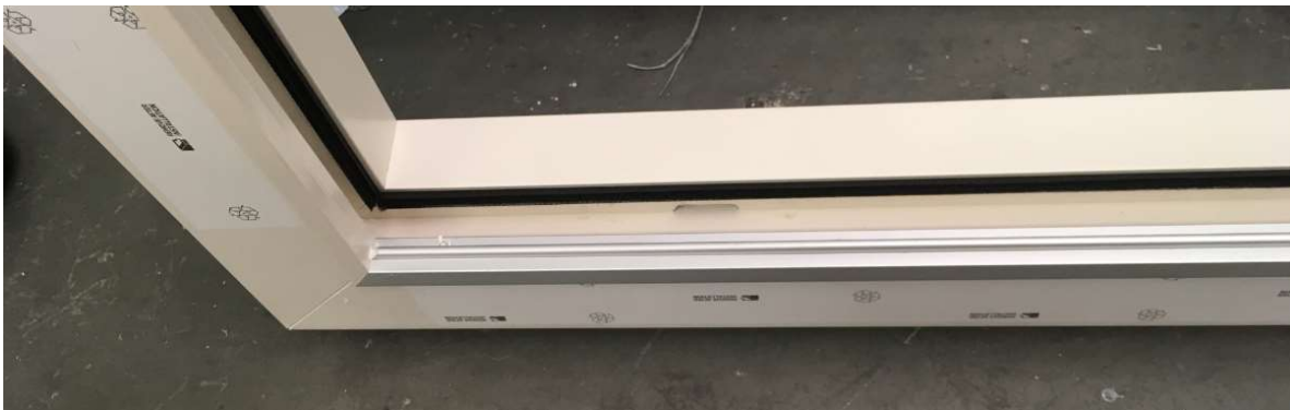
Schuifrail Multislide onderzijde hoek van uit binnenzijde
